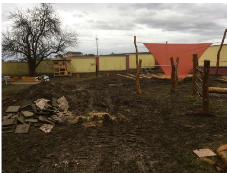
Rekonstrukce školní zahrady
