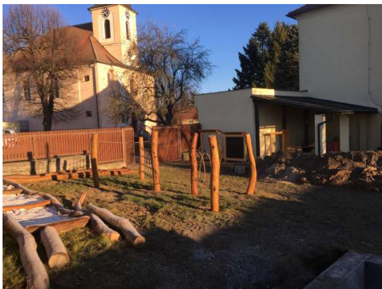
Rekonstrukce školní zahrady
