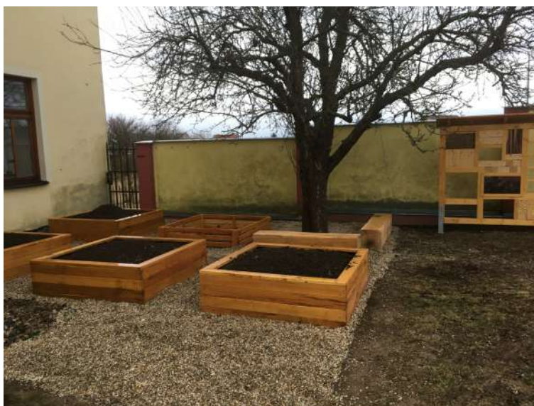
Rekonstrukce školní zahrady
