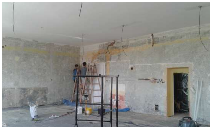
Opravy vnitřních prostor mateřské školy
