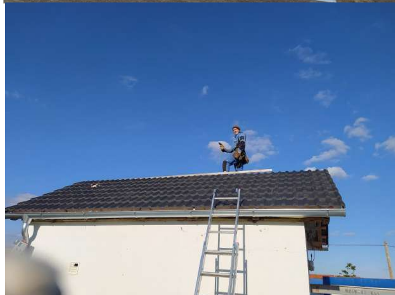
Oprava střechy ČOV v Hruškách
